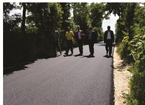
Asfaltimi i rrugës në Fshat të Ri
