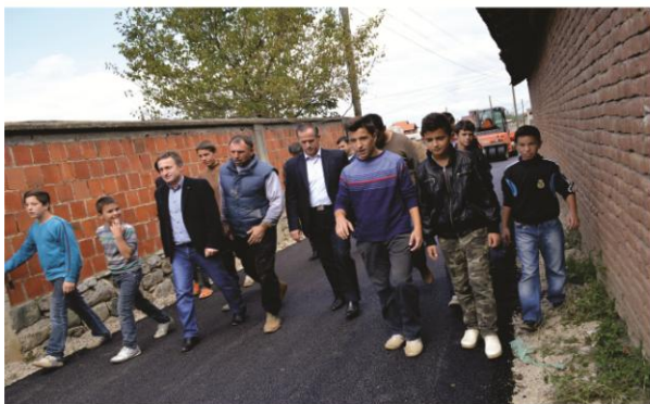
Asfaltimi i rrugëve në Llapqevë
