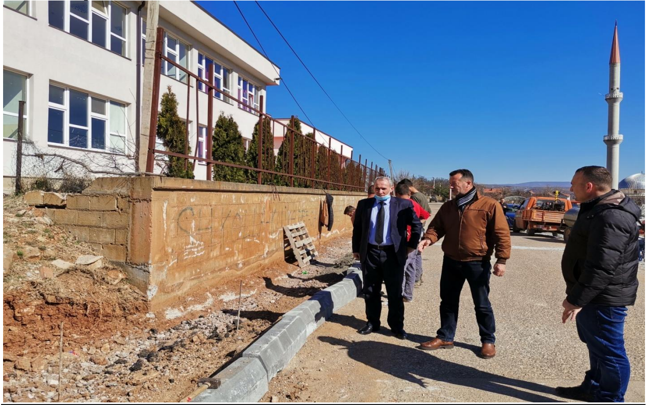
Kanë filluar punimet në ndërtimin e trotuarit në Shkozë
