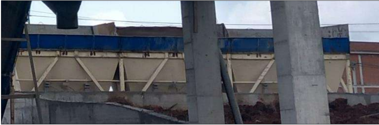
Figura 6. Bunkeret e Agregatit
